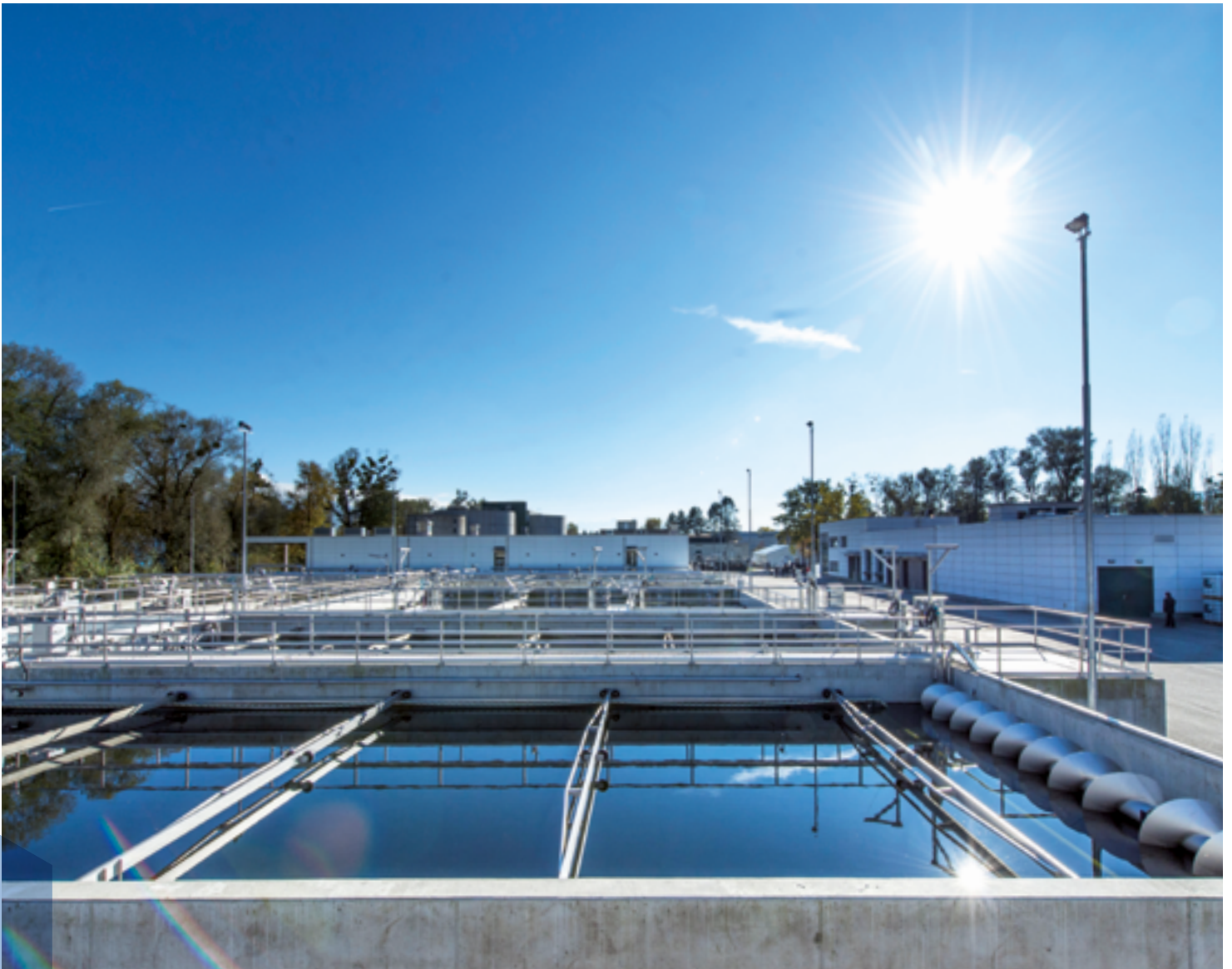
Abwasserreinigungsanlage Hofsteig, Vorarlberg
